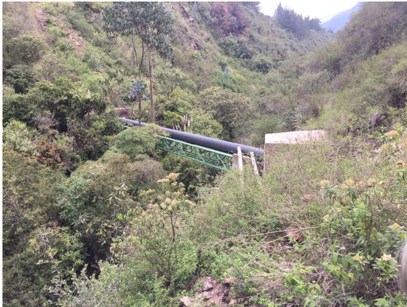
Foto 39 Cauce de quebradas zona Línea de Conducción
