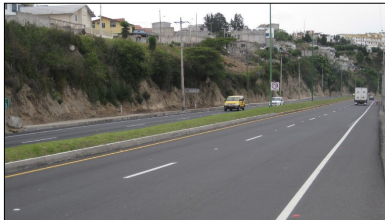
Figura 23: Vista hacia N. - Afloramiento de Cangahua en un talud a monte de la carretera. Debido a los parámetros geotécnicos que caracterizan la unidad, para estos taludes no se ha aplicado soporte adicional.
