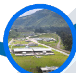
COMPONENTE 2 "AMPLIACIÓN PLANTA DE TRATAMIENTO DE AGUA POTABLE PALUGUILLO"
