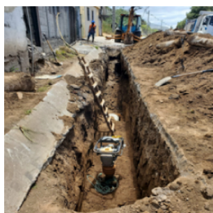
Alcantarillado para las calles cuero y caicedo, pasaje S/N, Alvaros, varias calles sector Bella Aurora. Parroquia Llano Chico.
