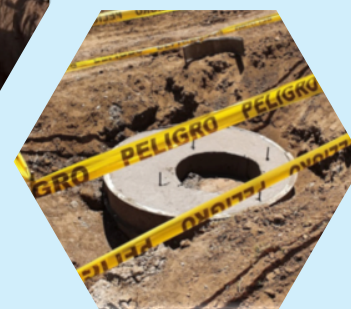
Alcantarillado combinado para los barrios Altos de La Argelia, 3ra. Etapa, parroquia La Argelia.
