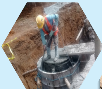
Alcantarillado para la población de Santa Rita de Archidona. Etapa 1. Cantón Archidona.
