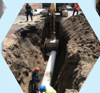
Extensión de redes de alcantarillado varios sectores de la parroquia Tumbaco, grupo 2
