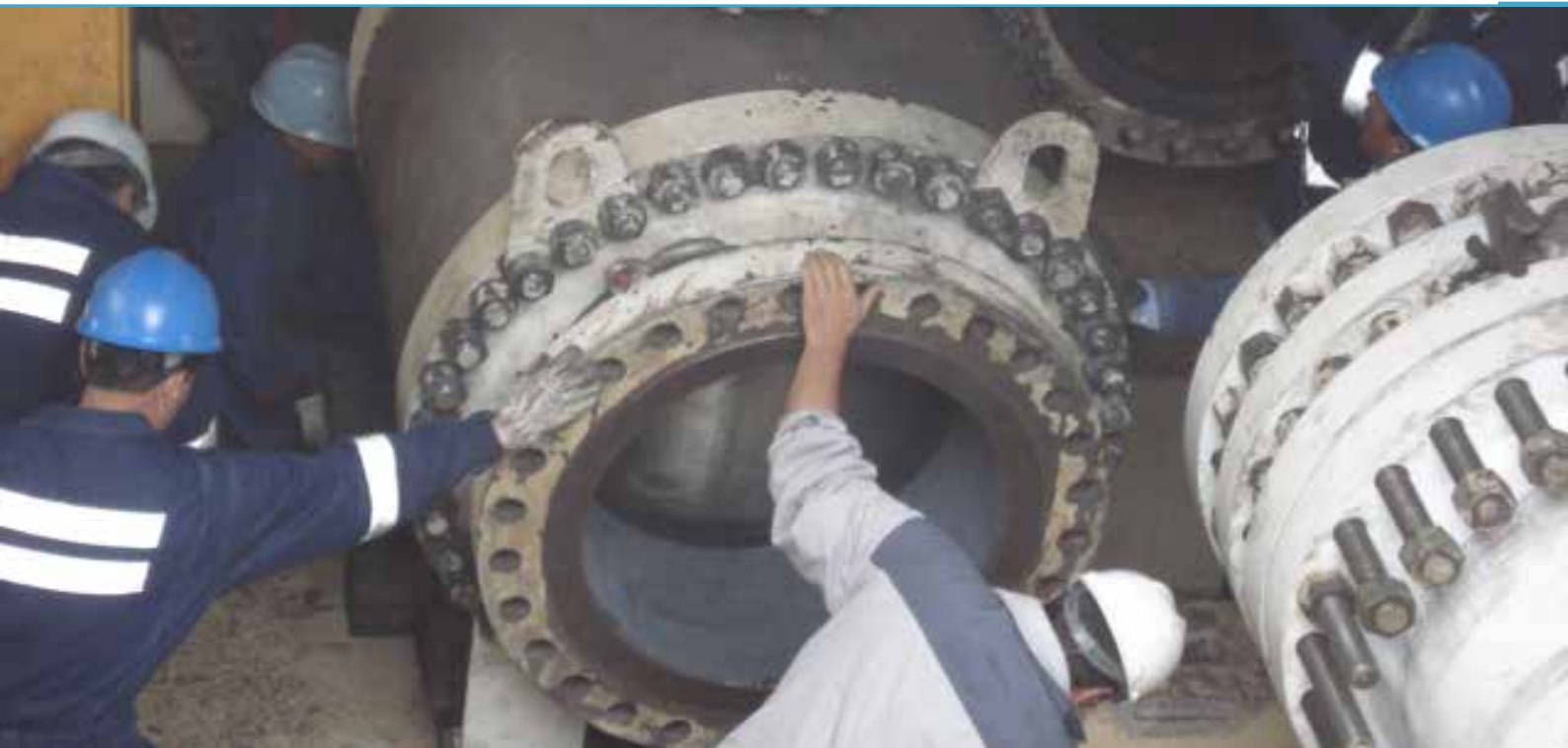
Válvula esférica en proceso de ubicación en la línea principal
