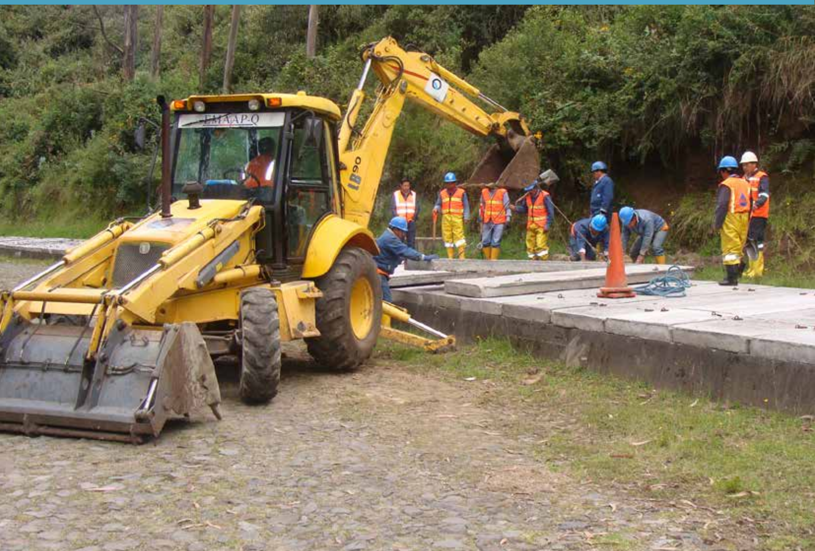
Instalación de las Losetas
