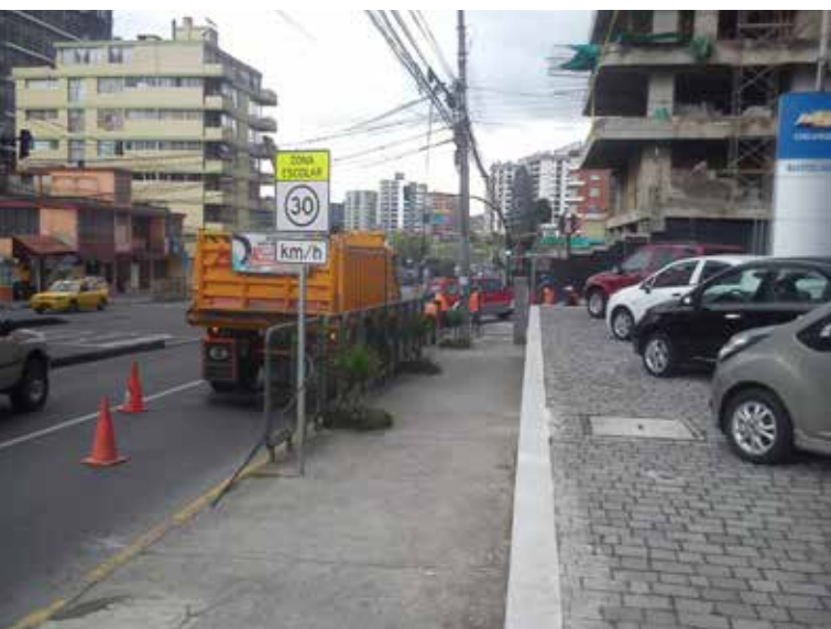
Limpieza de sumideros Sector norte de Quito
