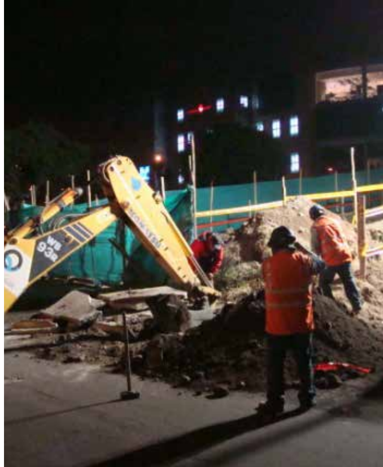
Recuperación de tubería de 16" en la Av. Mariscal Sucre y Fernández Salvador
