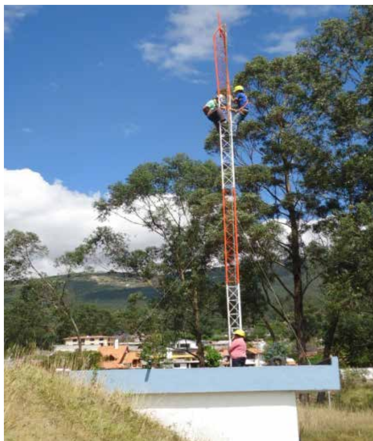
Instalación de torre de control de 15 m. Tanque Miranda. Oct./2013
