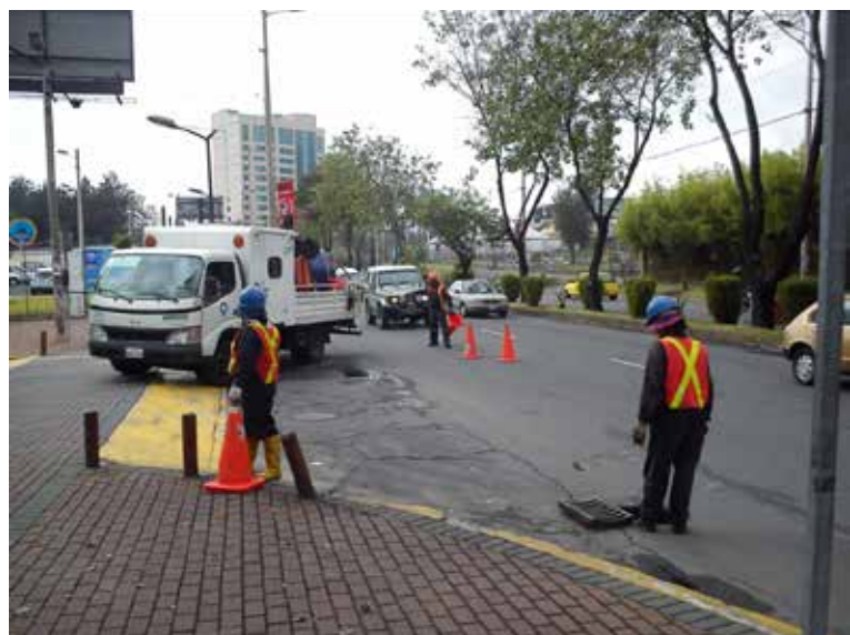
Limpieza de sumideros Sector norte de Quito
