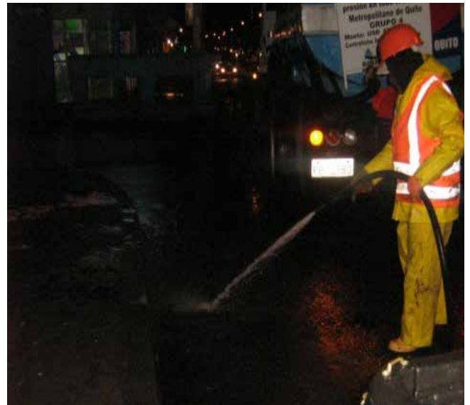
Limpieza de sumideros Sector sur de Quito
