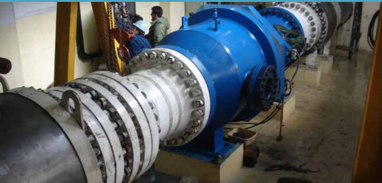
Se observa la línea principal de la Estación La Moca, luego de haberse instalado las válvulas polyjet esféricas y accesorios de 30 pulgadas reparados
