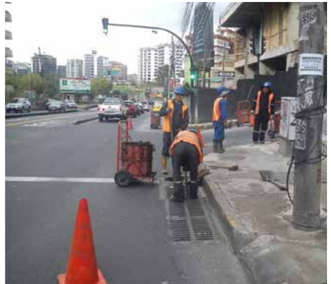
Limpieza de sumideros Sector norte de Quito
