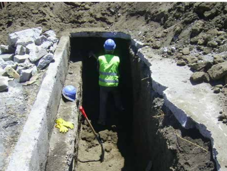
Excavación variante de tubería
