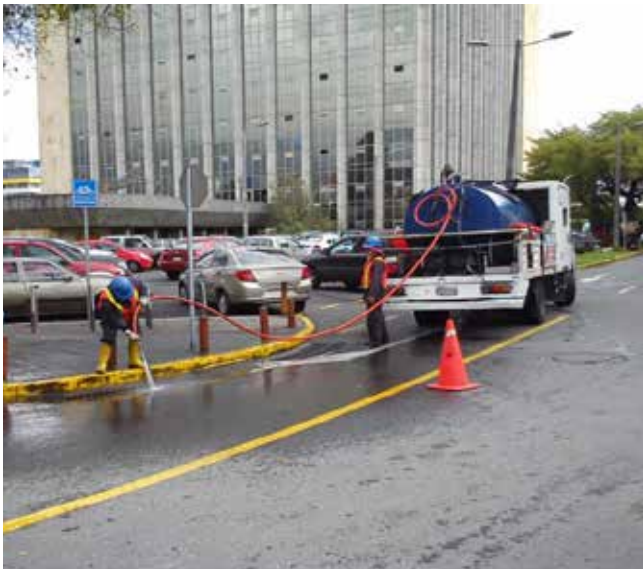
Limpieza de sumideros Sector norte de Quito
