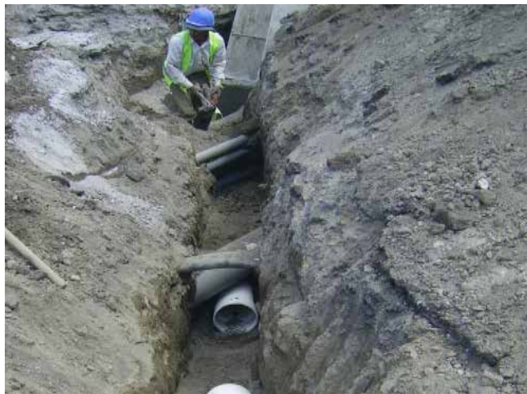
Instalación de tubería
