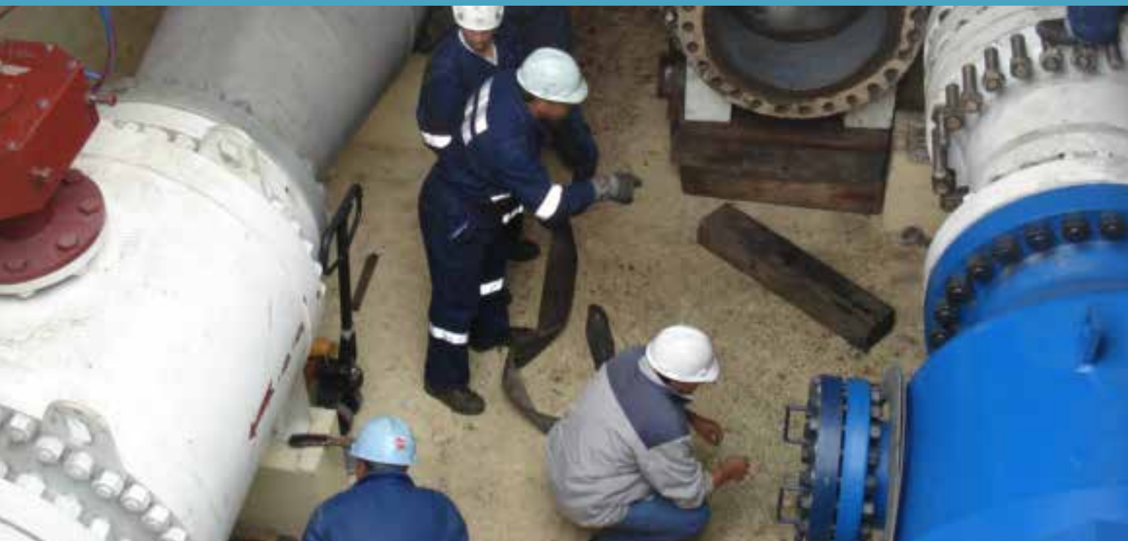
Se observa la válvula esférica de 30 pulgadas a ser montada agua arriba de la línea principal.
