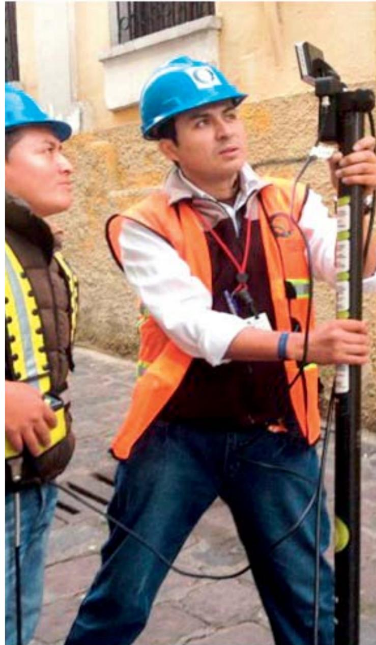
Inspección del sistema de alcantarillado, mediante cámara de poste
