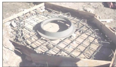
Figura 11 Forma y Armadura de la Tapa Pozo de Revisión de 48 Bloques
